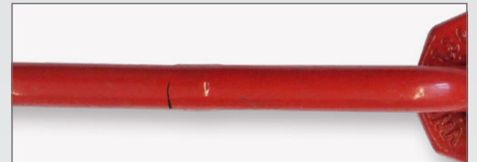
Pęknięcie ogniwa łączącego
