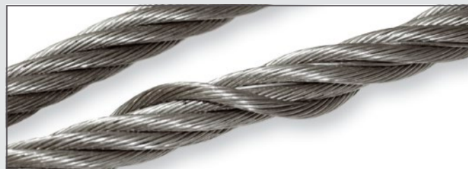
Poluzowanie warstwy zewnętrznej splotu
